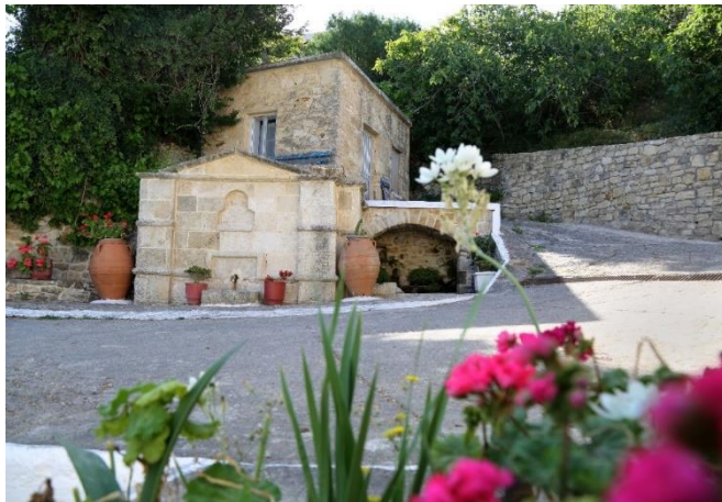
Παπαγιαννάδες , κοινοτική κρήνη. Αποτελείται από ένα δωμάτιο-δεξαμενή με δύο όψεις. Paragiannades , municipal fountain, consists of a hall - cistern with two facades.
