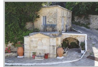
Παπαγιαννάδες, κοινοτική κρήνη. Αποτελείται από ένα δωμάτιο - δεξαμενή με δύο όψεις. / Papagiannades, municipal fountain, consists of a hall-cistern with two facades.
