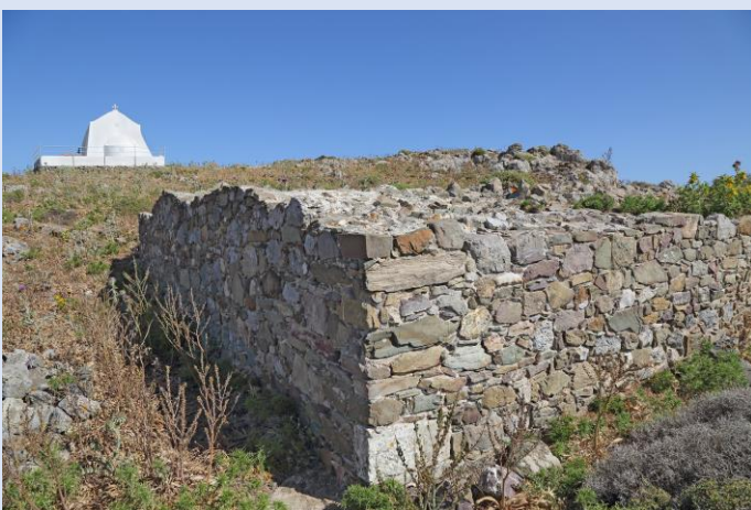
Η θολωτή δεξαμενή και ο ναός του Αγίου Γεωργίου στο βάθος
