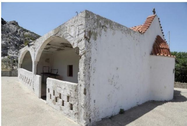
Κατάσταση διατήρησης των εξωτερικών επιχρισμάτων του ναού του Αγίου Γεωργίου
