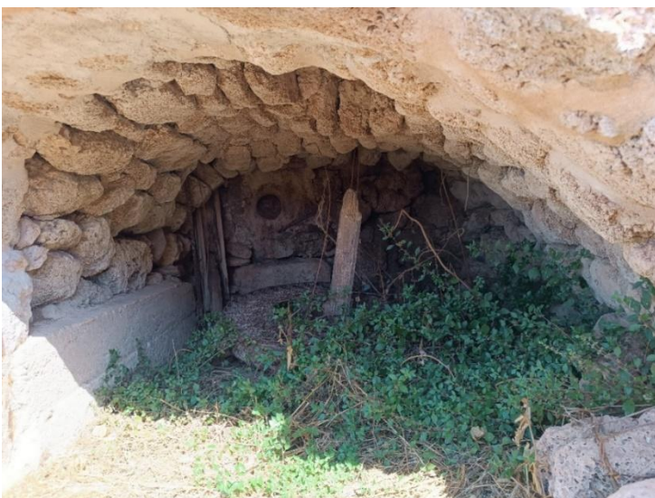
Εσωτερική άποψη του ζουριού του νερόμυλου του Μπριλάκη
