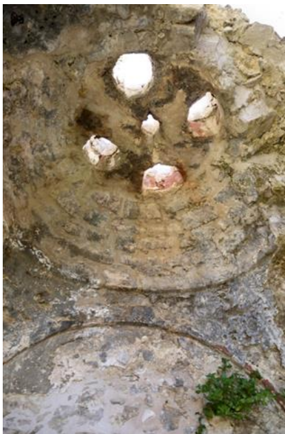
Ο τρούλος με τις φωτιστικές οπές και το πηγάδι στο χαμάμ του Χανδρά
