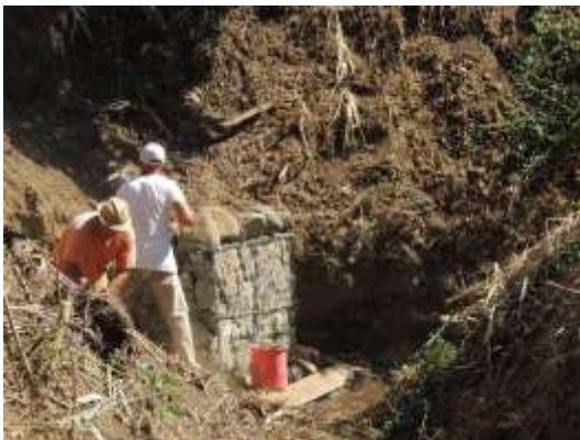
Εικόνα 8: Εφαρμογή διαχειριστικών μέτρων αποκατάστασης της βλάστησης: (α) απομάκρυνση φερτών υλικών, (β) απομάκρυνση ανταγωνιστικής βλάστησης, (γ) φύτευση παραποτάμιας βλάστησης, (δ) εγκατάσταση λιθοπλήρωτων συρματοκιβωτίων (gabions) για την σταθεροποίηση των πρανών της κοίτης
