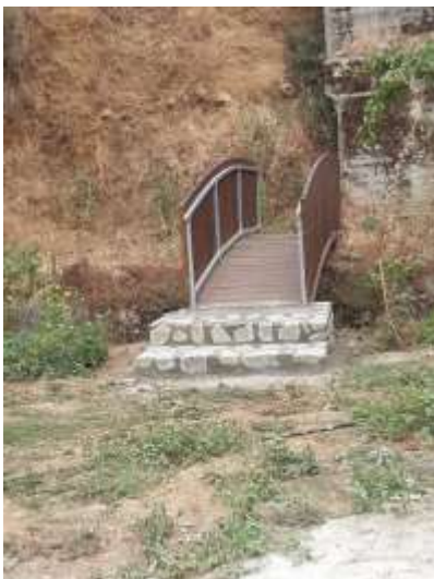
Εικόνα 10: Στο πλαίσιο της πράξης WaterWays υλοποιήθηκα βελτίωση της υφιστάμενης διέλευσης πάνω την κοίτη του ποταμού Κάμπος, εντός της ομώνυμης κοινότητας (πάνω: πριν την υλοποίηση της πράξης και κάτω: μετά την υλοποίηση των εργασιών βελτίωσης)
